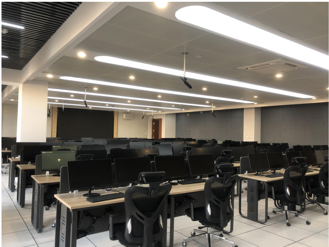
最先进的“云一体机”实训机房
